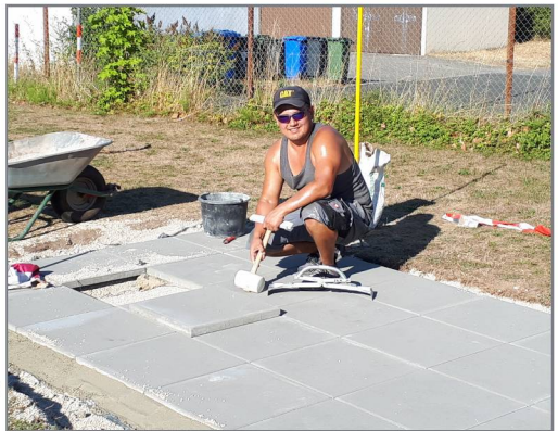
In größter Hitze arbeitet Sascha Pak am Fundament für die Spielerbänke.
